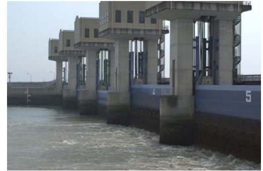
潮受堤防排水門からの排水風景
